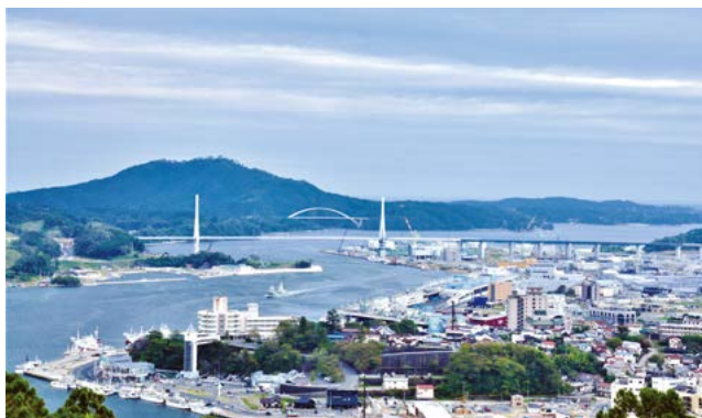
安波山から見た気仙沼市街 奥に見えるアーチが気仙沼大島大橋(鶴亀大橋)、手前が気仙沼湾横断橋
